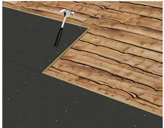
Asennus vanhan kattolaudoituksen päälle
